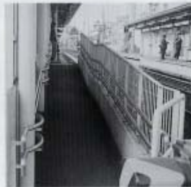
世田谷線 スロープ
