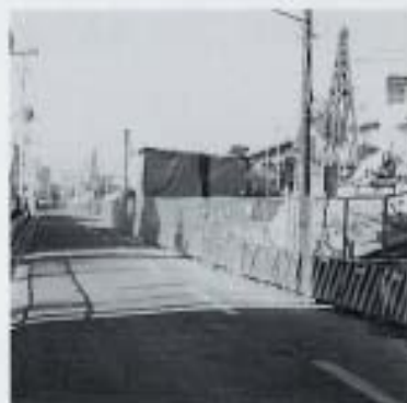
暗渠にする工事中
