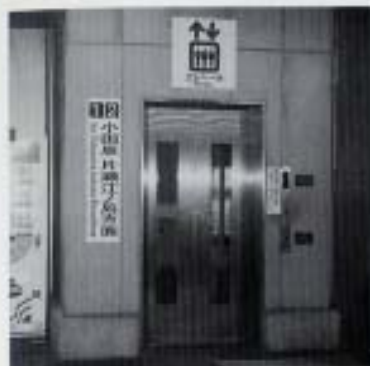
小田急線エレベーター
