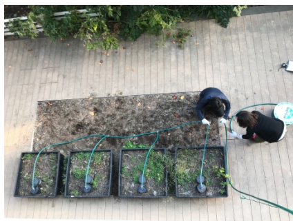
ホースの取り替え作業
