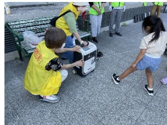
非常電源となる発電機
