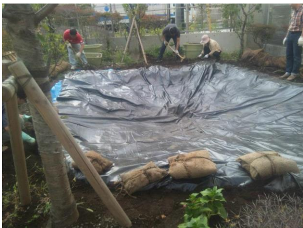
2011.10 みんなでブルーライナーを敷いて池の基礎を作っています。
