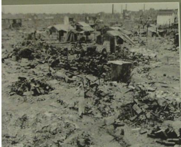
バラック小屋が建つ銀座地区
