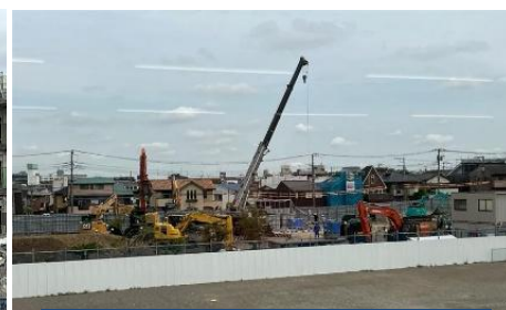
7/1(水) 現在、旧校舎は全て取り壊され、瓦礫を搬出しています。
