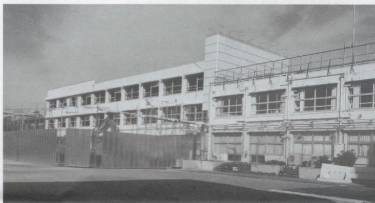
2022-11-13 校舎内部の解体は始まっています。
