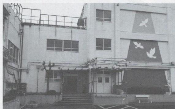
改築中の校舎入口です（昇降口）。
