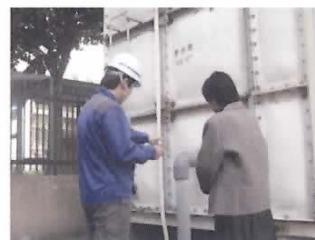
貯水槽水道の点検調査
